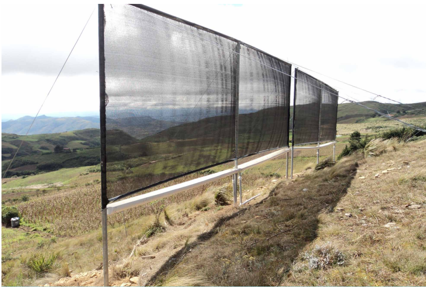
Los captadores colocados en la parte alta de las montañas interceptan las nieblas que pasan
