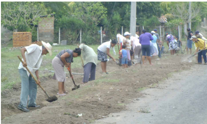
Apertura de zanjas previa colocación de las tuberías
