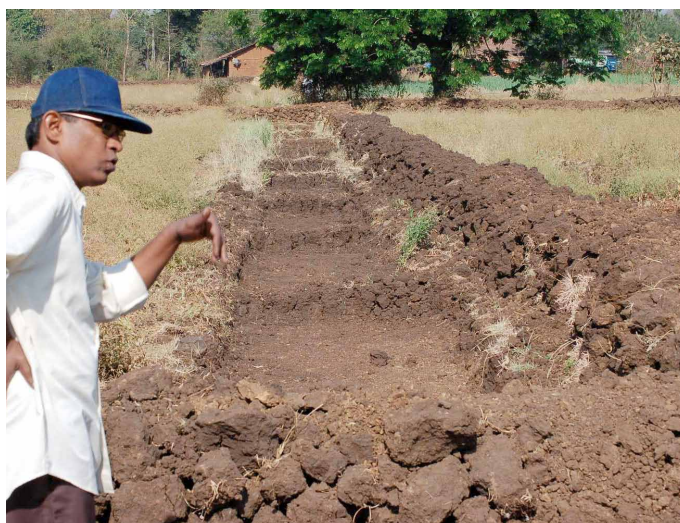
Ingeniero local guiando los trabajos de construcción
