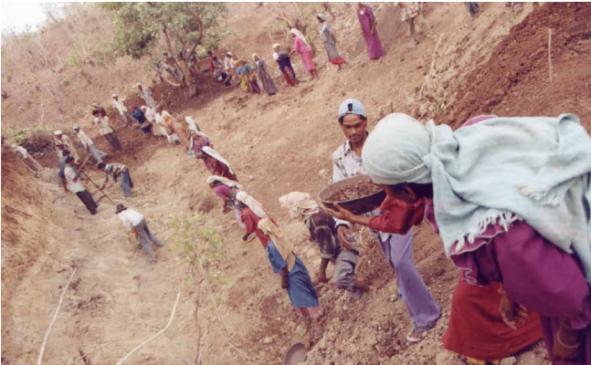
Trabajo colaborativo en la construcción de muros de contención
